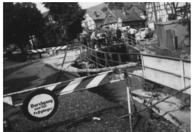
Hochwasserschäden am Krombach
