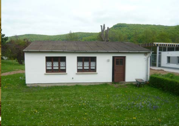
Auch das alte „Spielhofhaus“ wurde im Zuge der Neuerungen abgerissen
