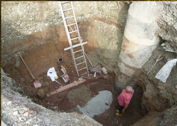
Eine neue Entwässerung zum Vincenzhaus wurde gelegt.
