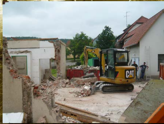
Am 25.06.2012 wurde der Mariensaal durch die Handwerker unsere Einrichtung abgerissen
