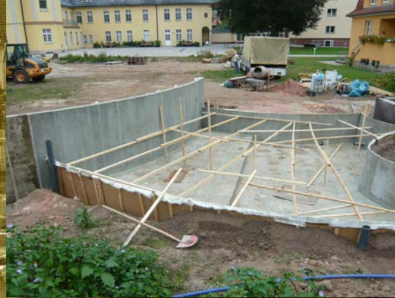
Eine große Teichanlage wurde von einer Spezialfirma aus Wiesbaden erbaut
